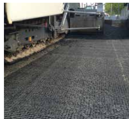
6 Aplicación de la capa de mezcla bituminosa
