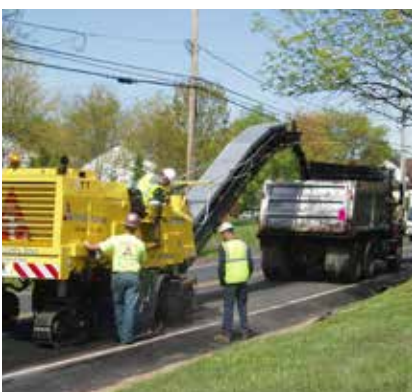
1 Fresado / Preparación de la superficie
