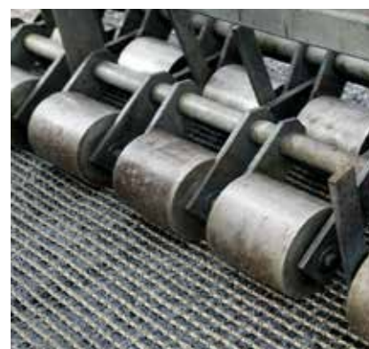
Compactación con rodillos individuales
