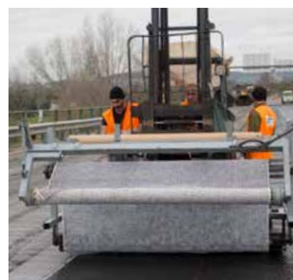
A1 - Viaducto de Coimbra
