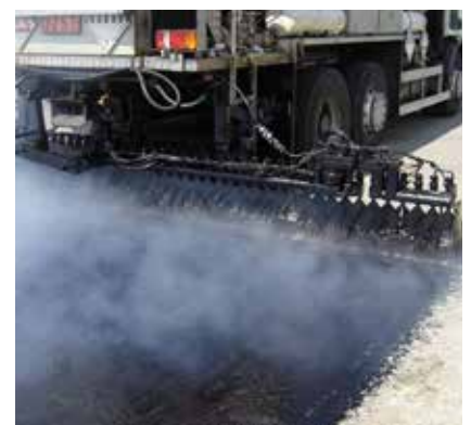
3 Aplicación de la emulsión bituminosa
