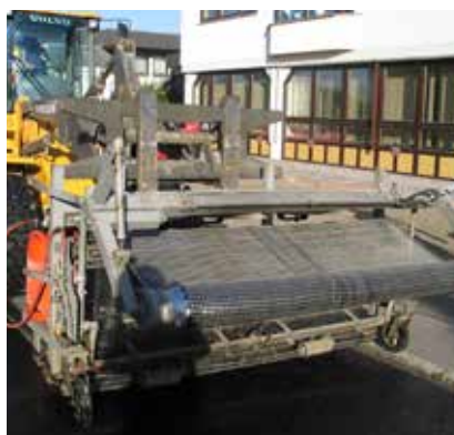
5 Aplicación por termofusión y compactación
