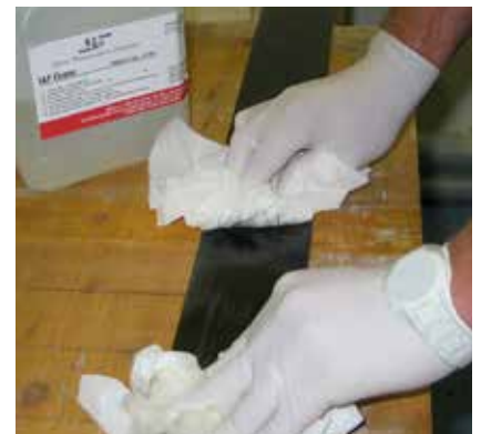
3 Limpieza de los laminados S&P C-Laminate
