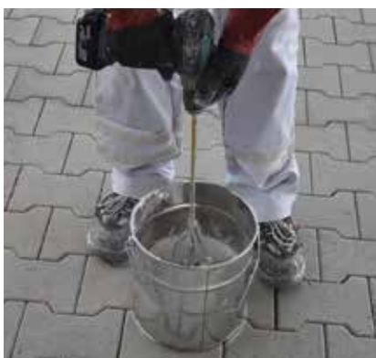
4 Mezclado del adhesivo
