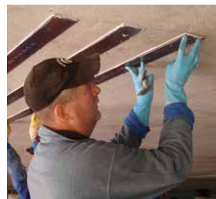
6 Montaje y presión del laminado sobre el elemento estructural
