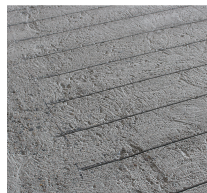
2 Limpieza de las aberturas
