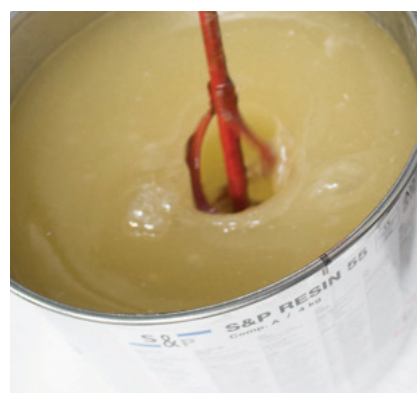
3 Mezcla del adhesivo
