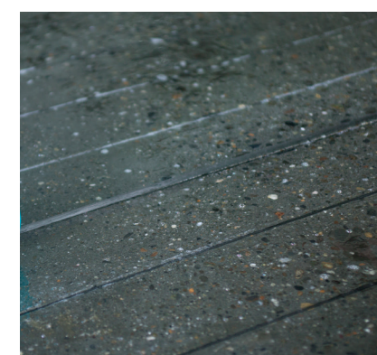
5 Colocación de los laminados
