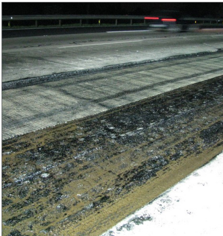
▲ Malla de refuerzo de asfalto S&P colocada sobre la capa de riego de adherencia
