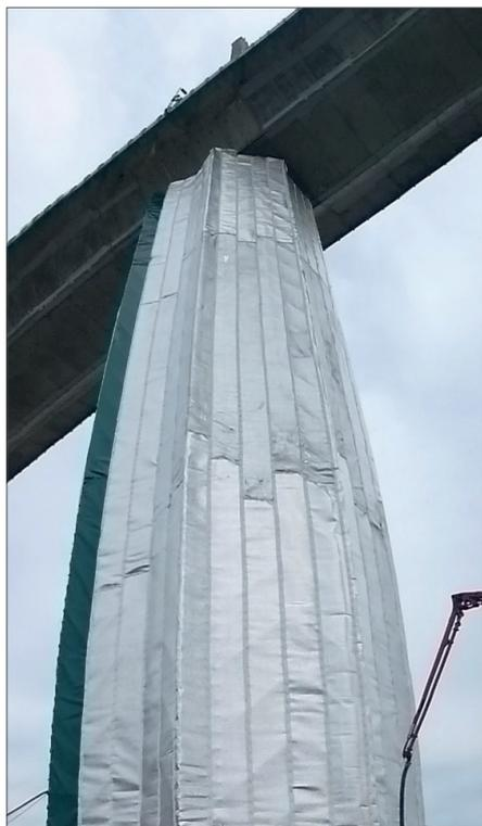
Dans le cadre d'un marché public de renforcement du Pont de Brotonne, S&P est intervenu comme fournisseur du système de renforcement. L'objectif du renfort était de palier à un déficit d'armature ayant pour effet des fissurations verticales de 2 piles de 50 m de hauteur.
