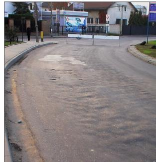
Daños visibles en la capa de rodadura, donde incluso se puede ver el dibujo de los adoquines hexagonales subyacentes.
